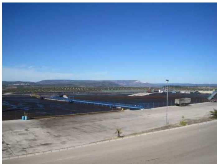
Figura 29 – Instalações da Central Valoriza San Miguel Arcangel, S.A.
