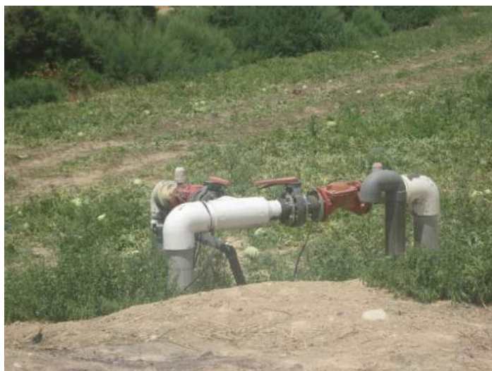
Figura 35 – Tubagem do sistema de distribuição do efluente suinícola
