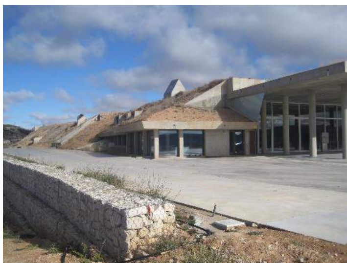
Figura 14 - Edifício semienterrado da Adega Entre Castillos
