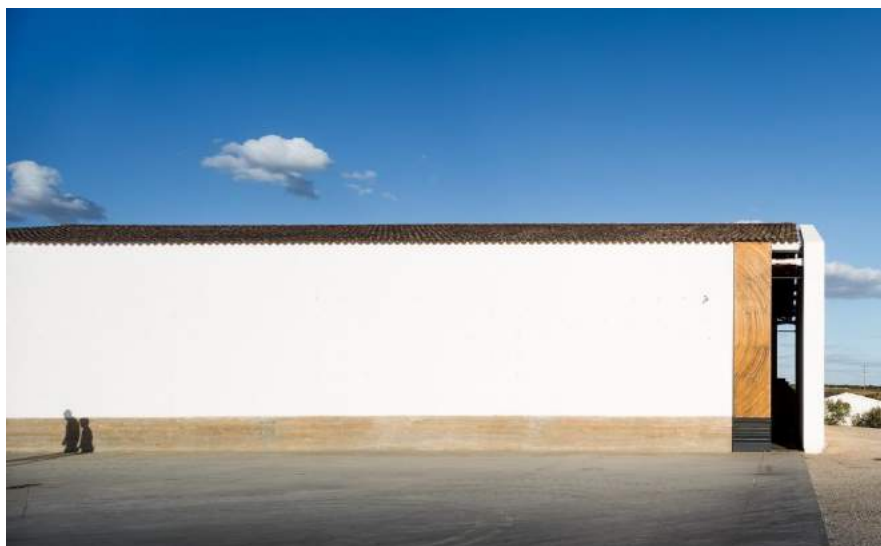
Figura 5 - “Adega dos Lagares” Exemplo de uma adega no Alentejo construída em taipa e com ventilação natural
