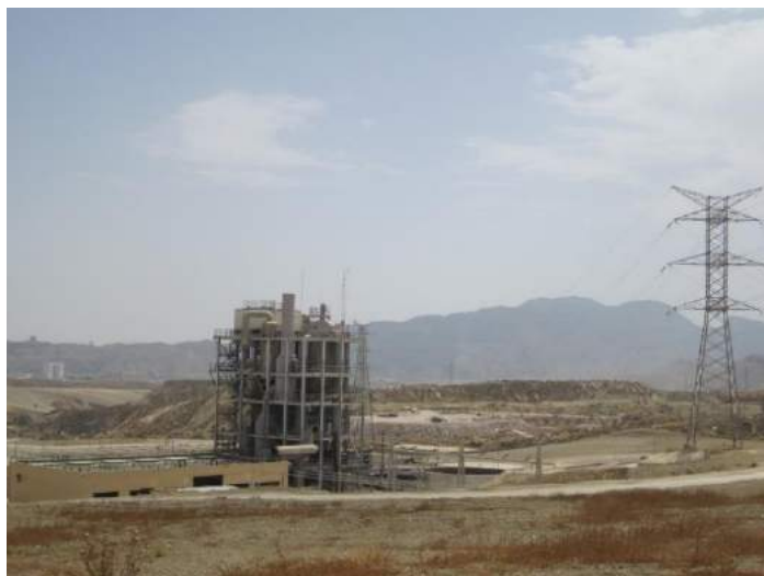
Figura 34 - Estação de tratamento de efluentes suinícolas
